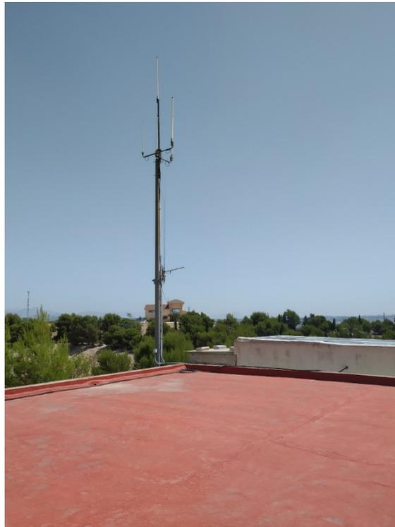
*Figura 14 Antena de comunicación vía radio entre depósito y bombeo*
